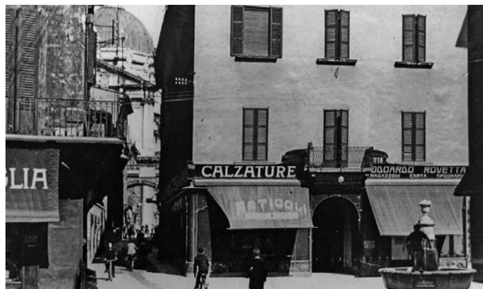
"Porosità" urbanistica: Contrada delle Pescherie, prima della demolizione
