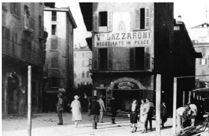
"Porosità" urbanistica: Contrada delle Pescherie, prima della demolizione
